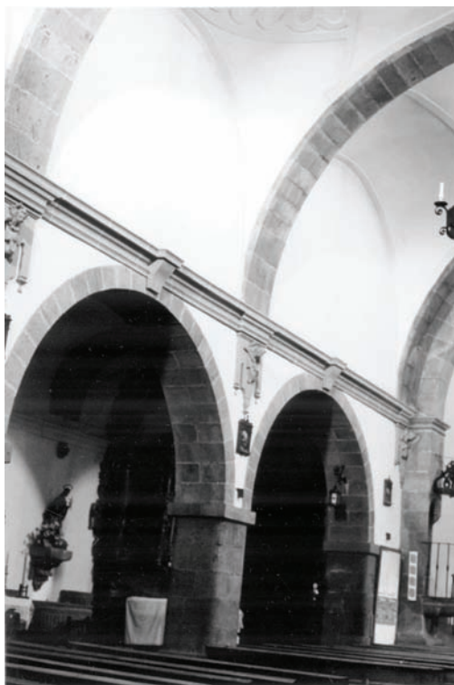
Iglesia parroquial de Pedro Bernardo. Nave central y lateral
